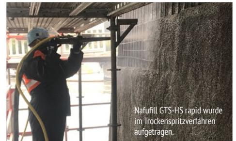
Nafufill GTS-HS rapid wurde im Trockenspritzverfahren aufgetragen.
