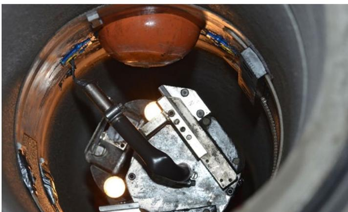
Mit *Konudur Robopox 10 fast* hat MC ein neues Epoxidharz entwickelt, das für die schnelle, kraftschlüssige Sanierung nicht begehbare Kanäle mit Robotertechnik geeignet ist. Der Name ist Programm, denn es härtet auch unter Wasser schnell aus. *Konudur Robopox 10 fast* ist zudem hoch chemikalienbeständig und bietet Planern und verarbeitenden Firmen noch mehr Flexibilität bei Instandsetzungsmaßnahmen.
